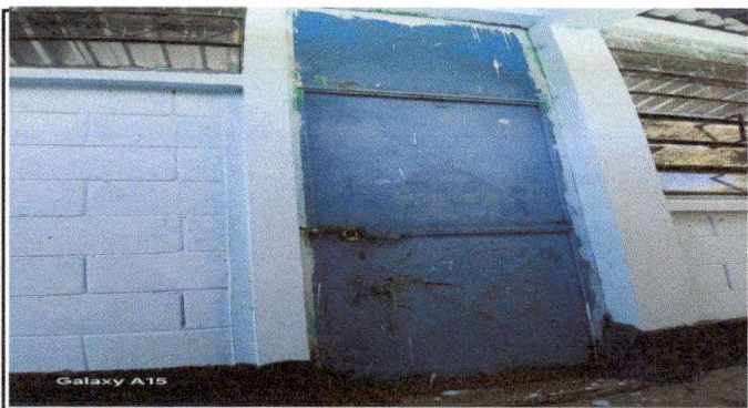
Foto 3: Aula 1 y 2 dirección y bodega: sustitución de chapa, mantenimiento a estructura (lijado, cepillado, sujeciones y aplicación de pintura)
