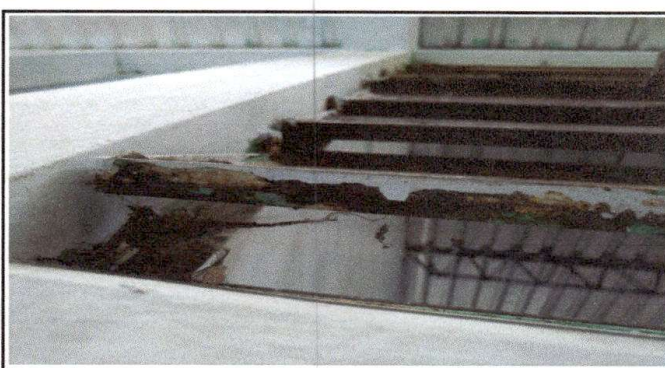
Foto 4: Área general de establecimiento: sustitución de estructura de metal de ventana (por pvc)
