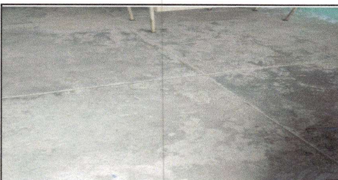
Foto 6: Área general del establecimiento: sustitución de piso de cemento liquido (por cerámico)
