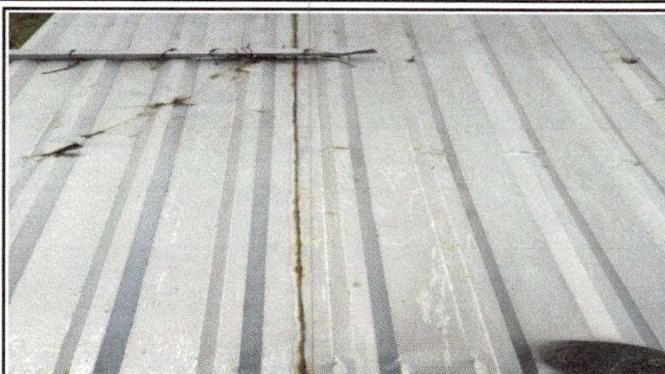
Foto 2: Área general del establecimiento: sustitución de lámina por lámina troquelada
